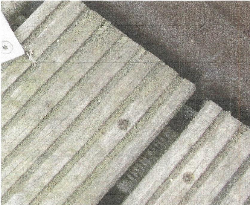
Eine Materialermüdung könnte z.B. das vollständige Durchrosten der Befestigungsschrauben bedeuten.
