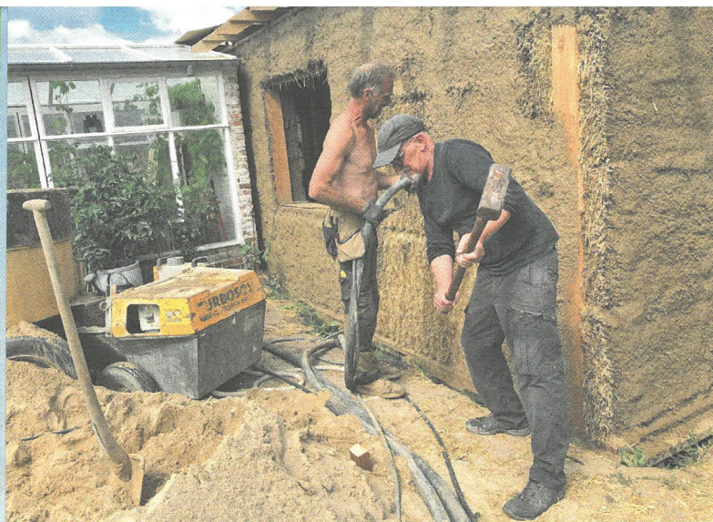
▲ Leret sprøjtes på med en pudsekanon.
