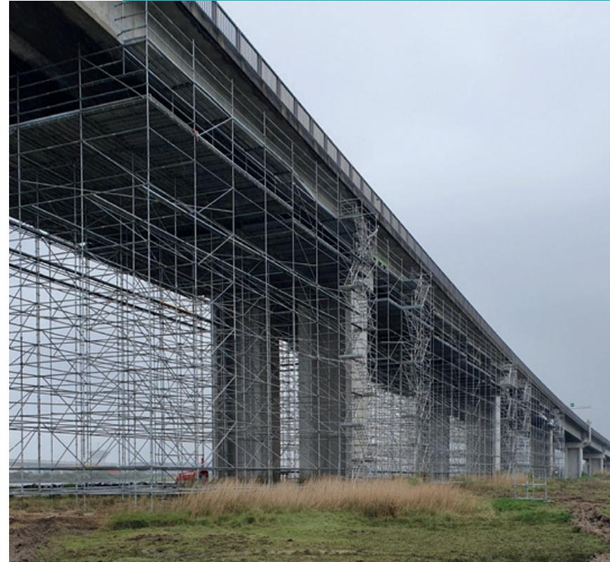
PCB a été missionnée par le Conseil départemental de Loire-Atlantique et Bouygues TP RF pour l'entretien du pont de Saint-Nazaire attaqué par les embruns marins. Elle a d'abord procédé à un nettoyage haute pression puis appliqué un inhibiteur de corrosion SIKA conçu pour les bétons armés.
