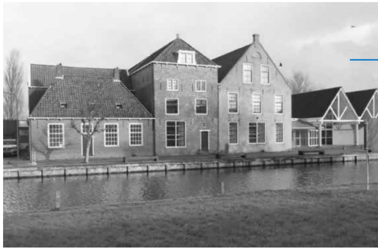
De monumentale panden Tichelaar, met rechts de voormalige showroom welke gesloopt wordt.
