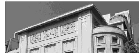
Achévé en 1913 ce bâtiment est précurseur du style Art Déco. Initialement conçu avec une structure en acier, son architecte, Van de Velde fait finalement appel à l'entreprise Perret pour la conception d'une ossature en béton ; Van de Velde est finalement évincé du projet. Auguste Perret habille la façade de plaques de travertin et le cadre de scène de plaques de marbre de l'Allier, où sont intégrés des bas-reliefs de Bourdelle.
