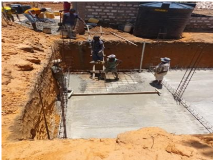
Bouwen van de ondergrondse watertank
