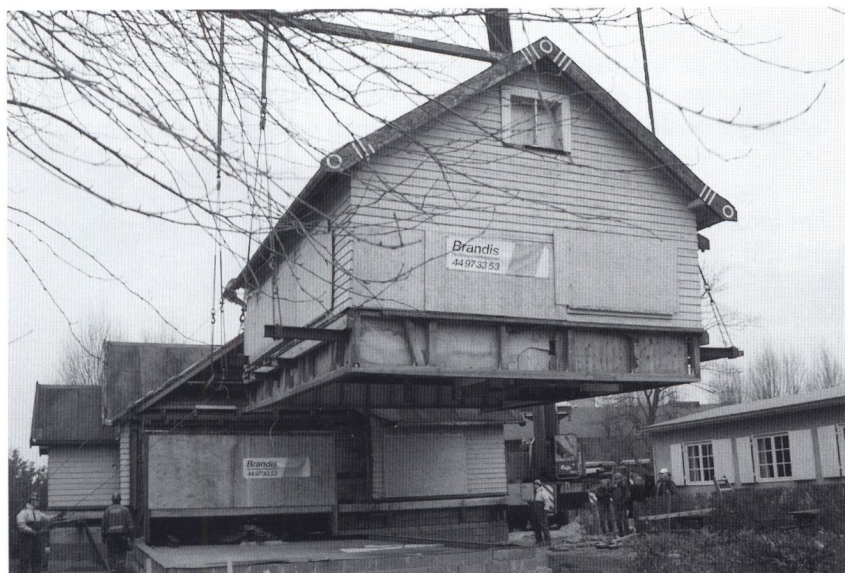
Flytning af radiostationen i december 2001.
