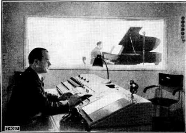
Fig. 30. Kontrolrum i radiohuset. Lydtæt glasvæg til det bagved liggende soliststudie. Overkontrolør L. C. Amorsen ved kontrolpulten og pianist Victor Fischer ved flyglet.
