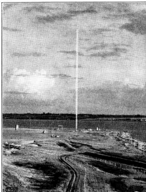
Fig. 38. Antennen for mellembølgesenderen i Kalundborg for program II. Masten, der er af stål og 140 m høj, danner selve antennen og hviler på en porcelænsisolator. Den forbindes med senderen med en 800 m lang fødeledning.
