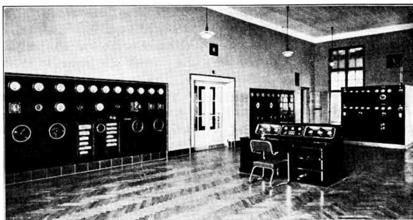
Fig. 36. Radiofonistationen i Kalundborg. Sendersalen for 60 kW senderen. I forgrunden manøvrerpulten.
