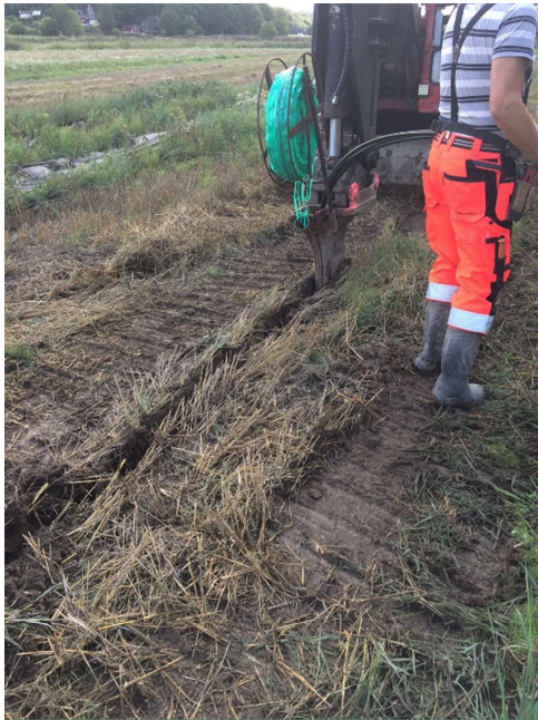
Grävrentreprenören Bjarne Rutgersson Entreprenad AB:s folk i färd med slangplöjning. En vanlig syn.
