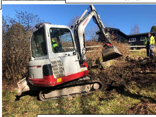
Får jag ge en särskild eloge till grävaren som tog ett järngrepp över förläggingsarbetet och som förtjänar stort beröm och tack för alla timmar som lagts på att leverera mer än ett bra arbete.
