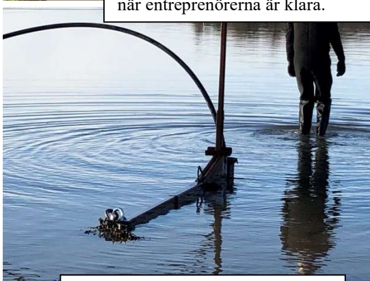
Här en bild på den ombyggda plogen för förläggningen i grunda vatten. Den lägger slangen 60 cm under botten redan från början.
