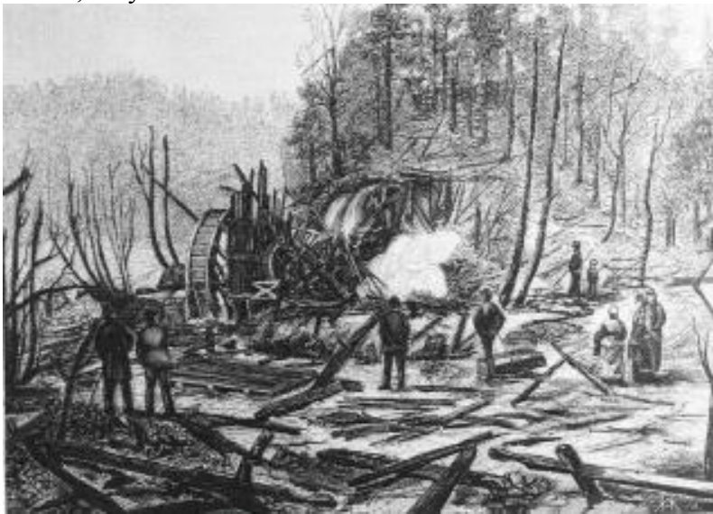
Kruttmøllen etter eksplosjonen. Vannet som drev vannhjulet kom fra høyre i bildet fra Liandalens dam (Fint folk i bratte bakker)
