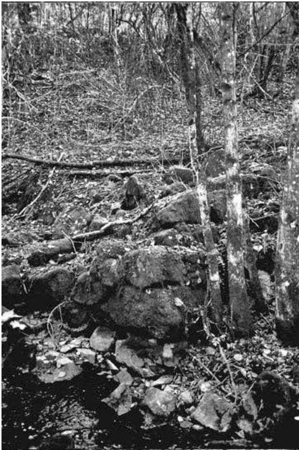
Bildet viser en av saghuspilarene på sørsiden av elva, der vi finner i alt åtte slike rester etter fundamenter, fire på hver side. Foto: AS
