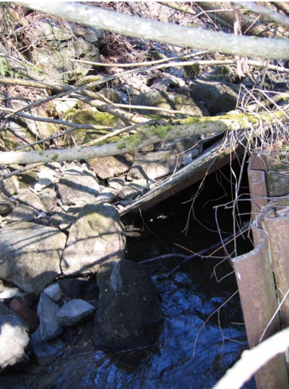
Figur 18. Klypa ved Leirskallen. Elva flyter under stålplater som bærer en privat oppfylling.
