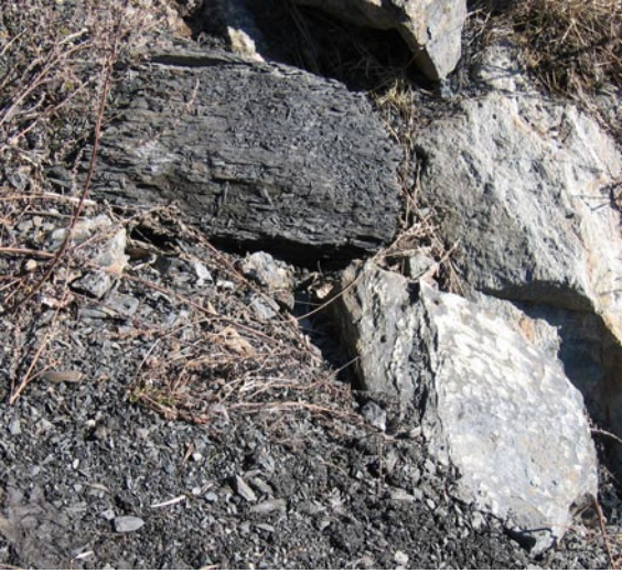
Figur 17. Alunskifer viser at fyllmassen kommer fra Oslo sentrum.
