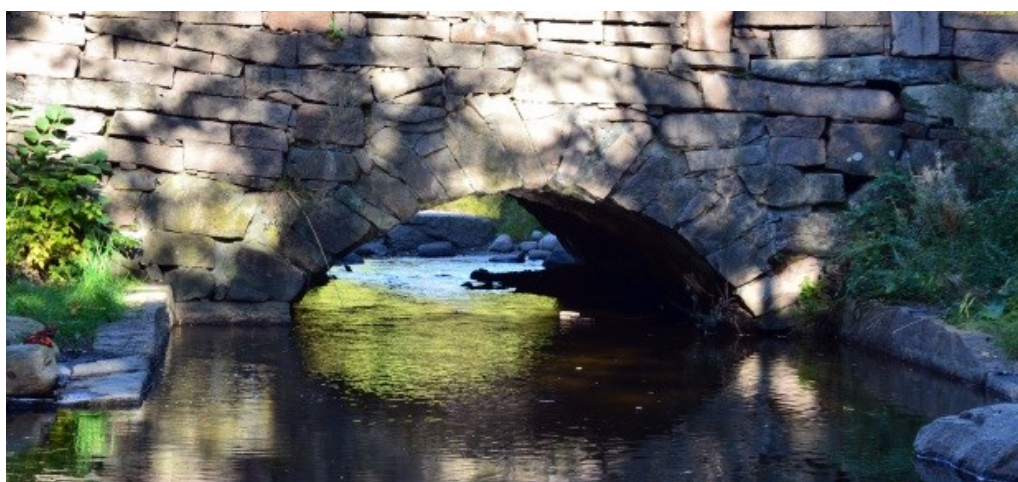
Figur 5. Steinbru over Alna ved Terje Noreides plass ved Kalbakken.
