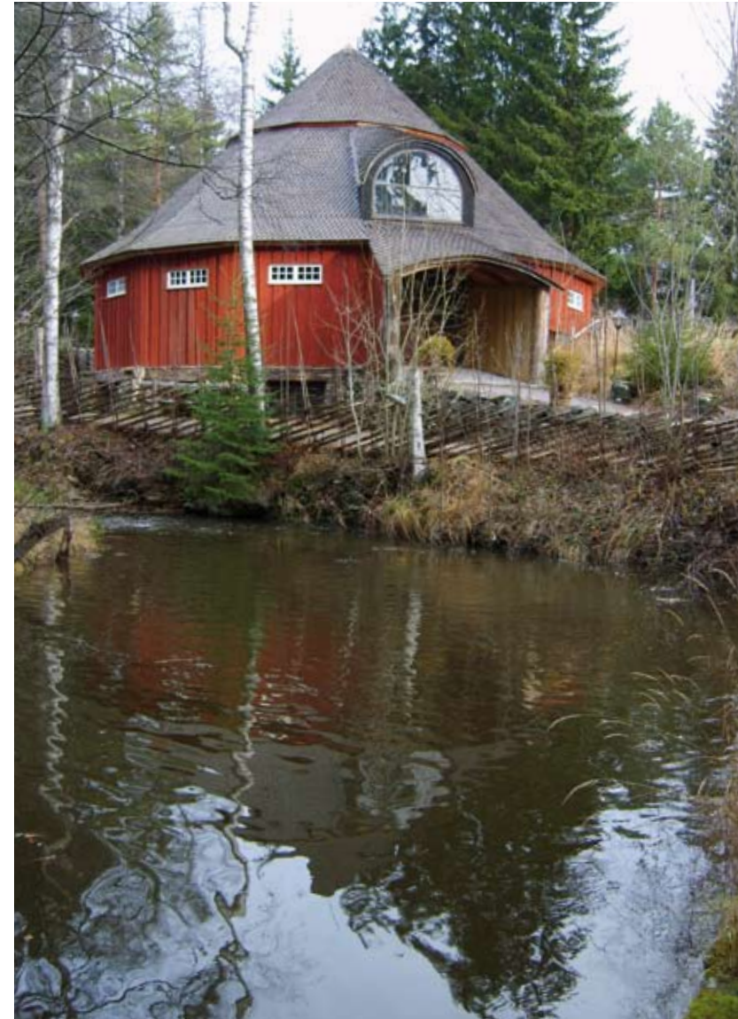
Kristianiasvingen 1 ved Styggedalsbekken ble oppført av Eivind Eckbos Legat som ridehus tidlig på 1930-tallet. Bygningen er senere restaurert og ombygget til selskapslokale av nåværende eier Hotel Norge AS.
