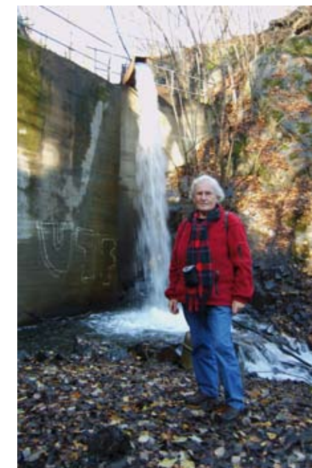
Forfatteren ved Leirfossen – før restaurering.
