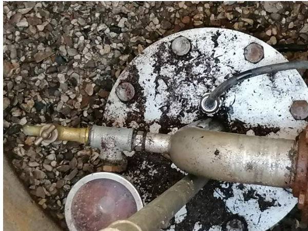
Billede 13 prøvehane og manometer
