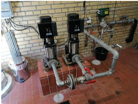
Billede 24 De 2 udpumpere
