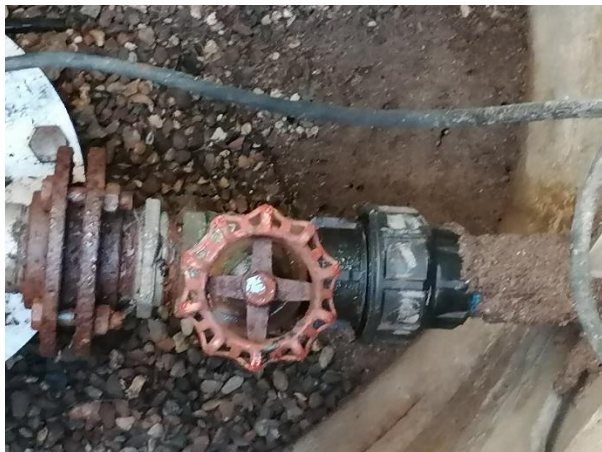
Billede 14 ældre messing skydeventil
