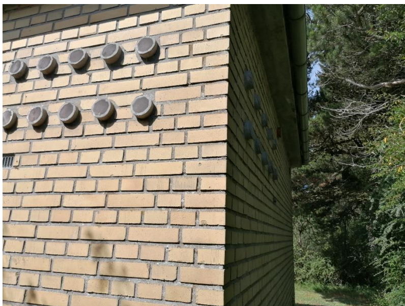
Billede 5 Indsugning bemærk de vender nedad.
