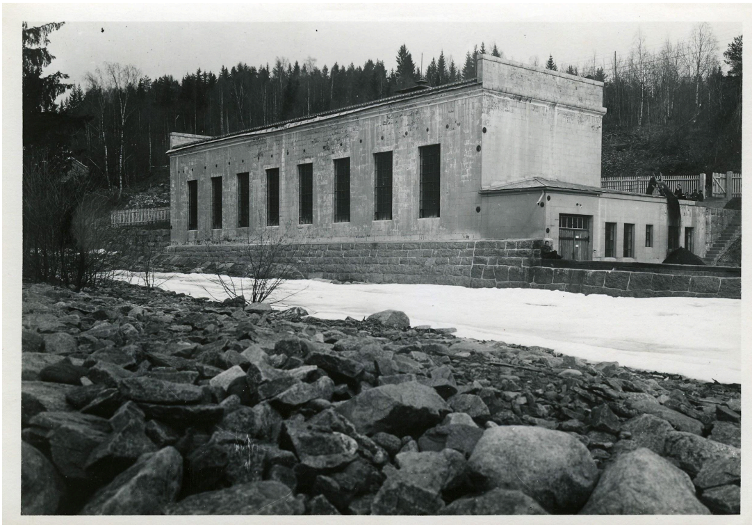
Foto av Hammeren kraftstasjon.
