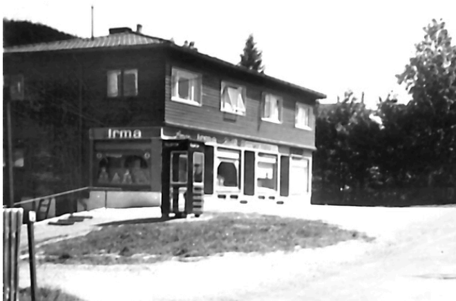
Foto av Finnerud's forretningsbygg.
