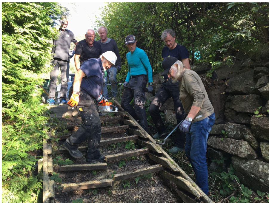
Riving av den gamle trappa: Foran f.v.: Harald Krokstrand (konstruktør og byggeleder) og Olav Solbjør. Bak f.v.: Halvor Floden, Jens Strøm, Stein Erik Kruse, Snorre Lægran og Runar Kårtvedt.
