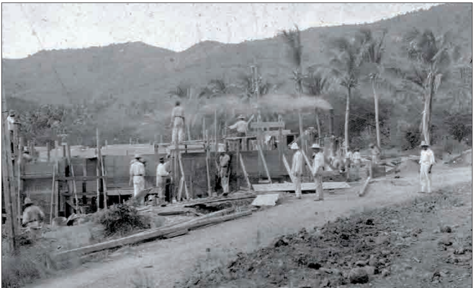
Figur 10. Støbning af fundament til elektricitetsværket. Nyborg Lokalhistoriske Arkiv.
