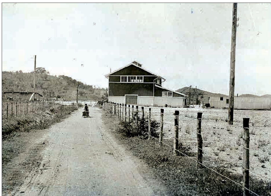
Figur 15. Elektricitetsværket set fra landsiden. Museet for Søfart.
