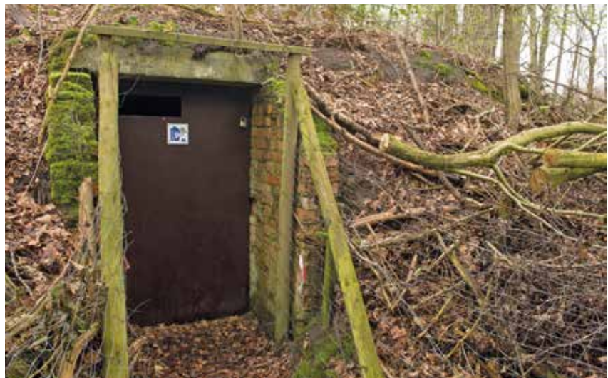
De bekendste vleermuizenbunker in Het Leen (foto: Ludo Goossens)
