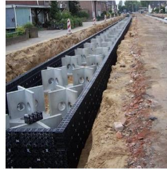
Aanleg van zeer ruime wortelstraat in Nijmegen
