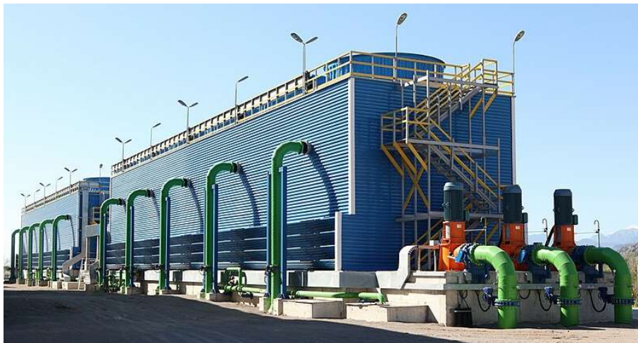
Figur 6-4: Et moderne kjøletårn med som bruker både vifter og kjølevann. Foto: Cenk Endustri (Wikimedia Commons).
