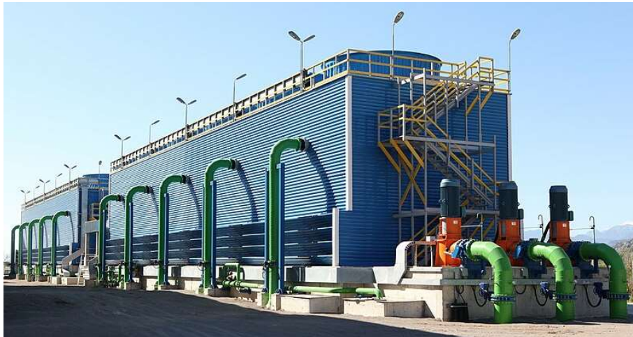
Figur 6-6: Et moderne kjøletårn med som bruker både vifter og kjølevann. Foto: Cenk Endustri / Wikimedia Commons.
