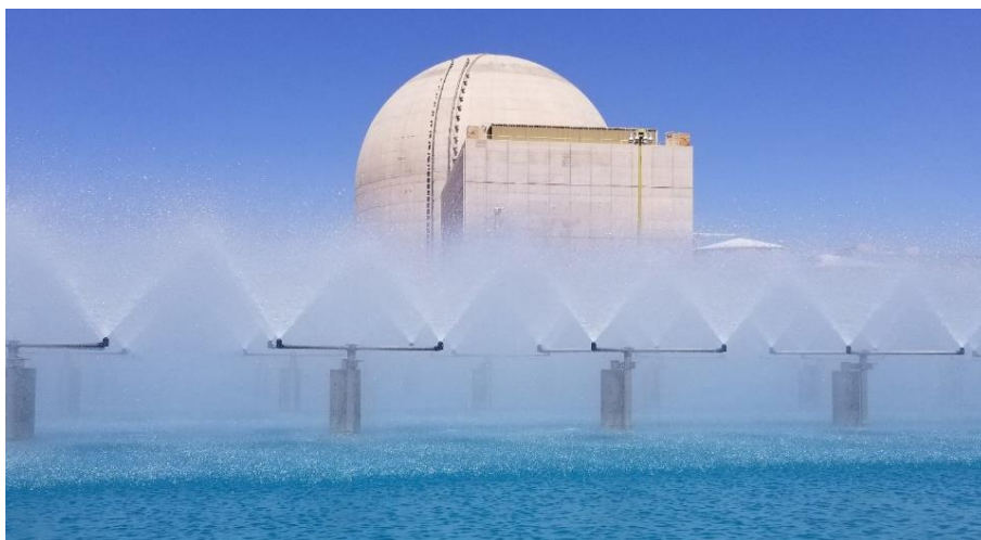
Figur 22: Et kjølebasseng med vanddyser ved kjernekraftverket Palo Verde. Kilde: U.S NRC [44].
