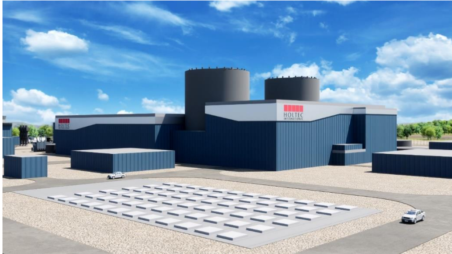
Figur 48: Holtec SMR-300. I forgrunnen ses lageret for brukt brensel. Kilde: Holtec.
