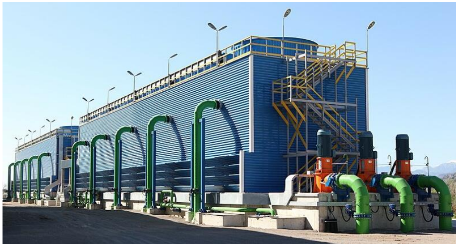
Figur 21: Et moderne kjøletårn med som bruker både vifter og kjølevann. Foto: Cenk Endustri / Wikimedia Commons.
