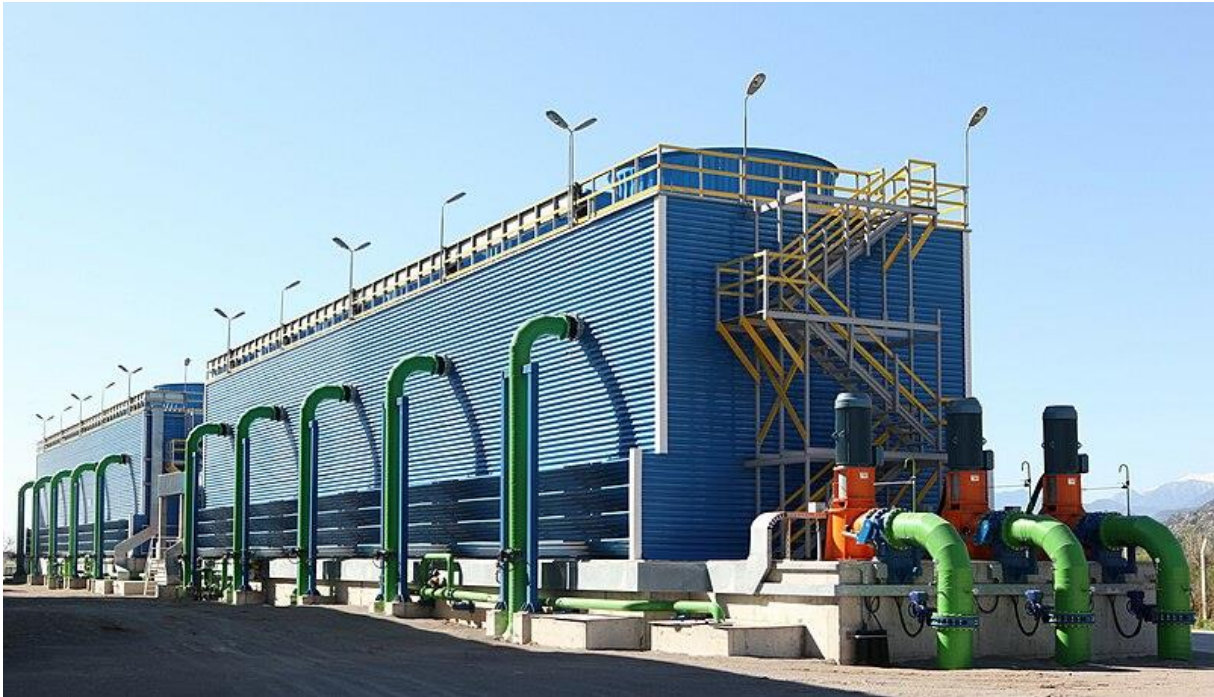
Figur 1: Et moderne kjøletårn med som bruker både vifter og kjølevann. Foto: Cenk Endustri (Wikimedia Commons).
