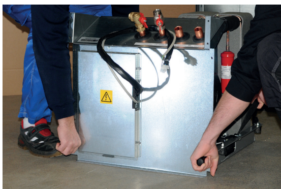
6. Lyft kylmodulen med hjälp av bärhandtag och bärremmar.
