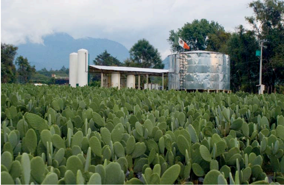
Foto: Zamna Aké Montiel. Muestra una vista de la planta de generación de biogás a partir del nopal, motivo de este trabajo, que inició operaciones en 2010, en Zitácuaro, Michoacán
