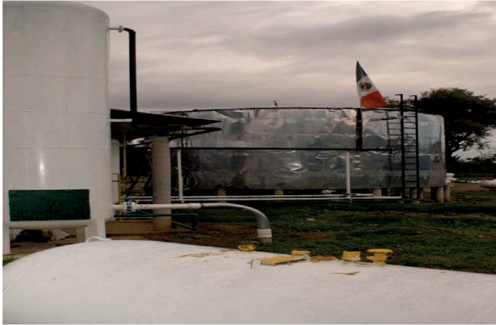
Planta terminada y en operación, diciembre de 2010
