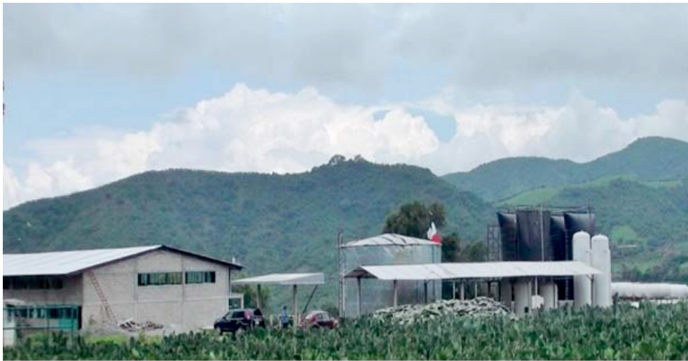
Planta piloto de generación de biogás con nopal, en Zitácuaro, Michoacán, en operación desde 2010
