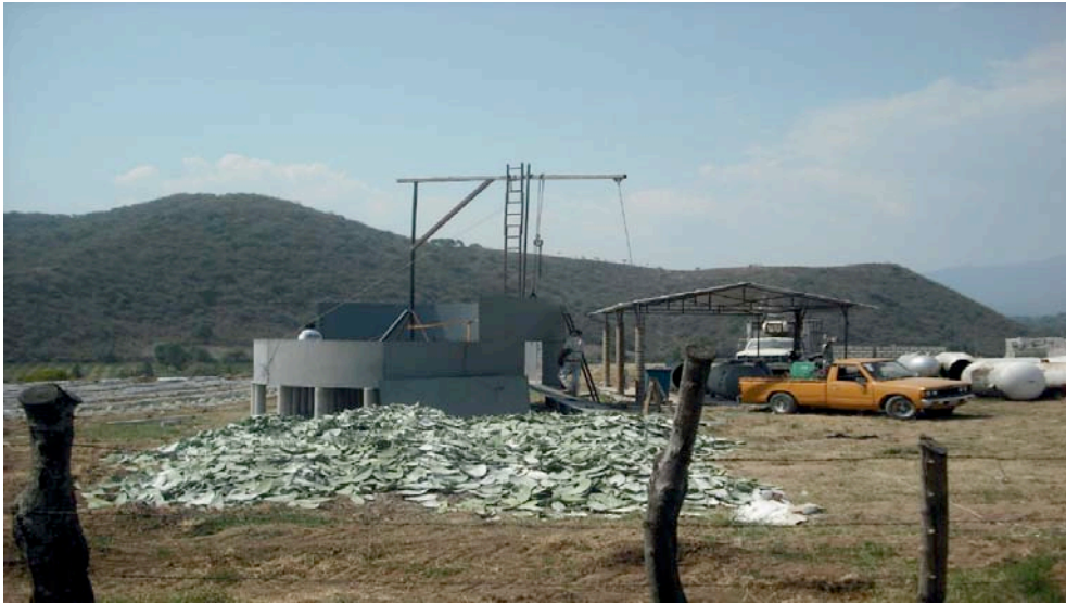
Capacidades del biodigestor: 100 m 3 , asentado sobre pilotes de 1 metro de altura, con tapa hermética, para procesar 8 toneladas de nopal al día y alimentar con biogás a un generador de 35.5 kwh, para producir 450 y 600 m 3 de biogás
