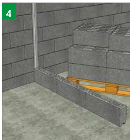
Färdigställ första skiftet. Glipor mellan block och vägg/golv fylls med bruk.
