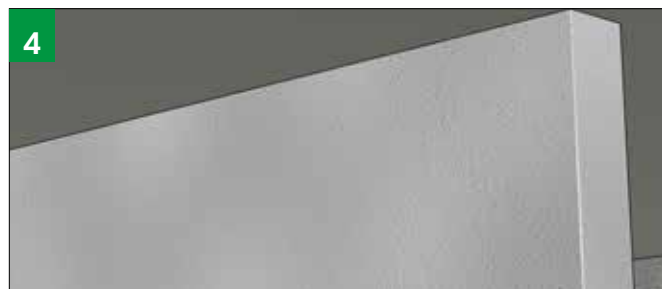
4 Putsa väggen med Gypsum Naturgips.
