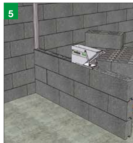
Placera murarlådan i början av skiftet och fyll med Weber Flexoheft. Justera öppningen för önskad bruksmängd, dra fram strängarna.
