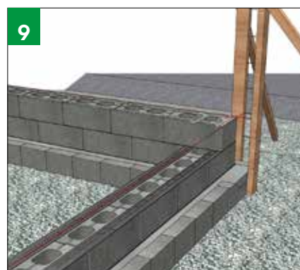
9 Eventuell armering läggs i bruket innan blocken för nästa skift läggs på och justeras.
