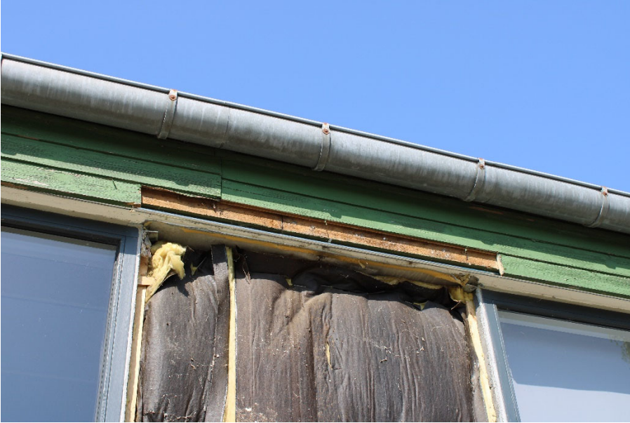
Figur 11. Facadeelement udtaget.
