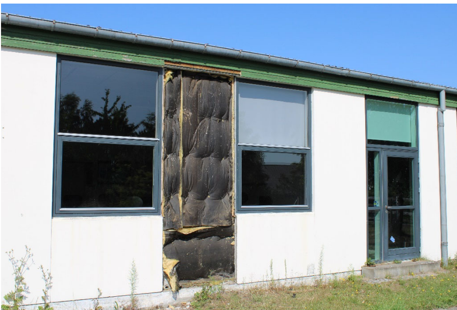
Figur 10. Facadeelement udtaget.
