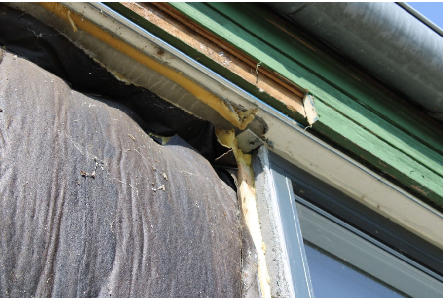
Figur 12. Facadeelement udtaget. Bemærk lille stålplade benyttet til fastholdelse af facadeelement (ikke korroderet).
