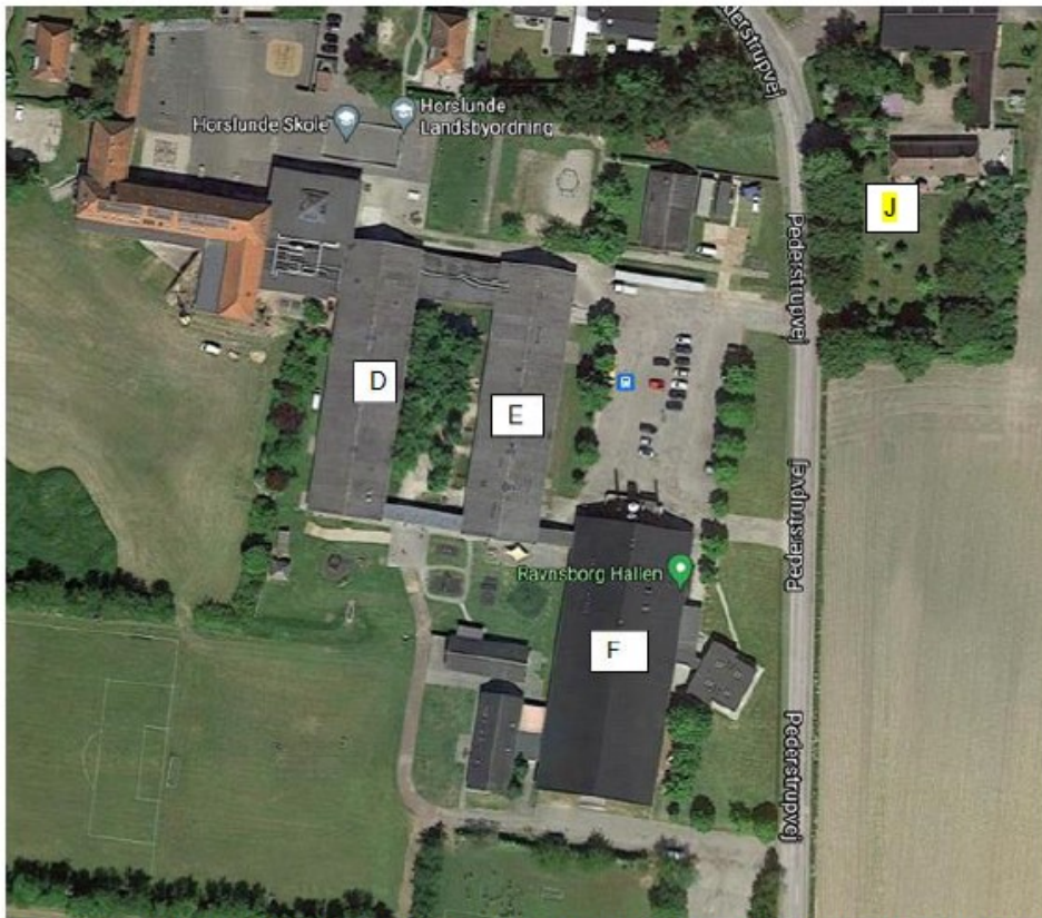
Bygningerne er opført med bærende facader i præfabrikerede betonelementer. Facade er opbygget af 2
