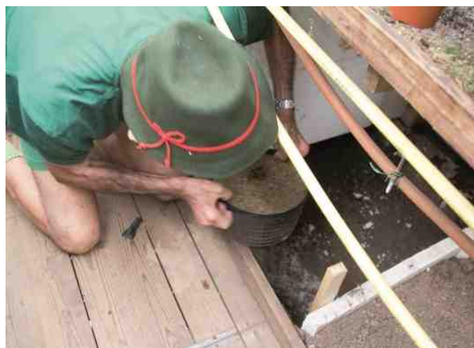
Foto 4: En nu in de kuil
