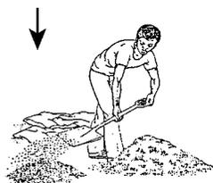
Com a pá desloque esta pilha para outro lado do chão e, de novo, para o sítio aonde estava originalmente.
