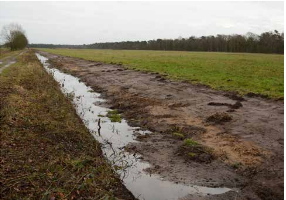
Berm waaruit houtopslag is verwijderd, verondiepte en geherprofileerde gracht.
