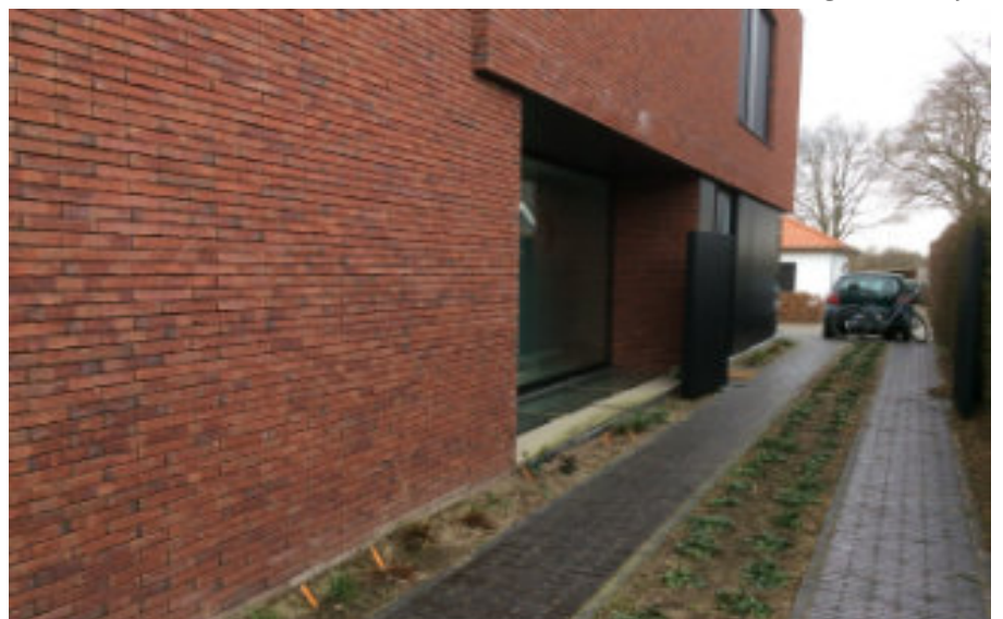
Het vlakke deel van de oprit is verhard als karrenspoor met ruimte voor planten en infiltratie van regenwater
