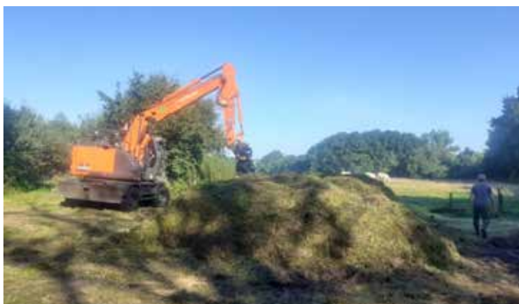
De hoop wordt laag voor laag opgebouwd en luchtdicht afgedekt met landbouwplastic. (Foto's: Ted Overmeer)
