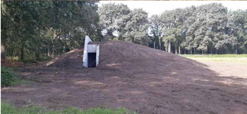
Vleermuiskelder in aanbouw (Foto's: Bart Hoeymans)
