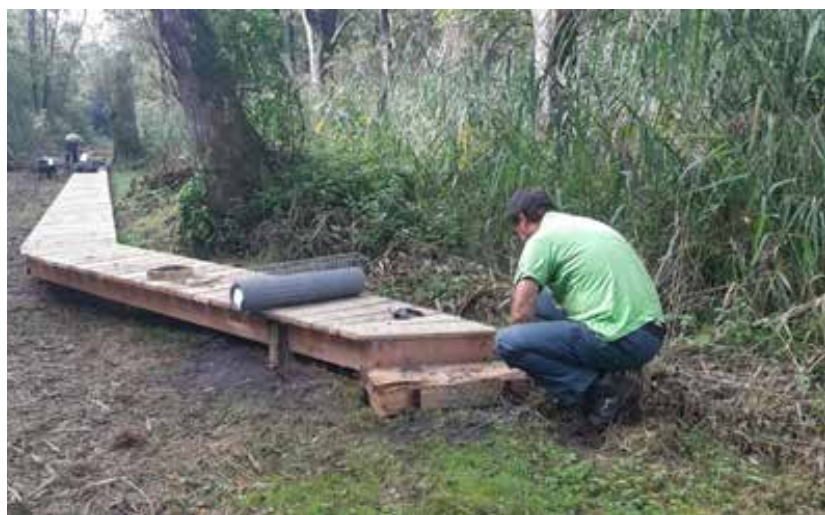
afwerken deel van knuppelpad (Foto: Bart Hoeymans)
