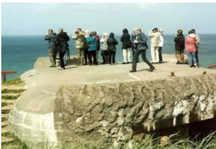
Bunkeren ved Bulbjerg
