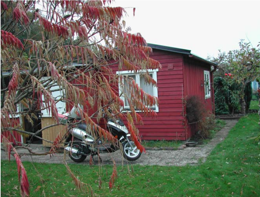
Panelbyte från stående panel till liggande fjällpanel i trädgård 71.
