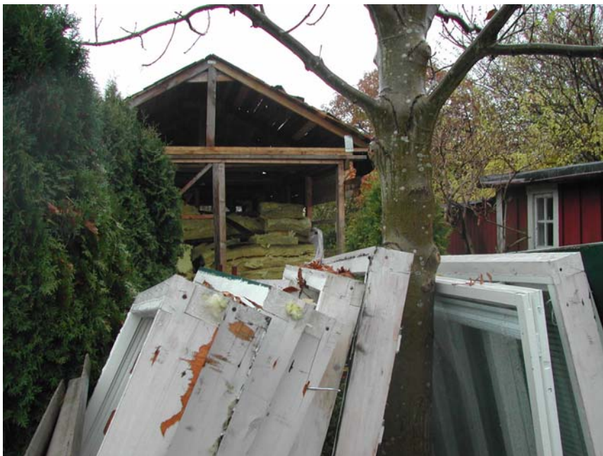
En påbörjad nybyggnation av en kolonistuga på Åragatans koloniområde som är lite större än den gamla som ses till höger i bilden.
