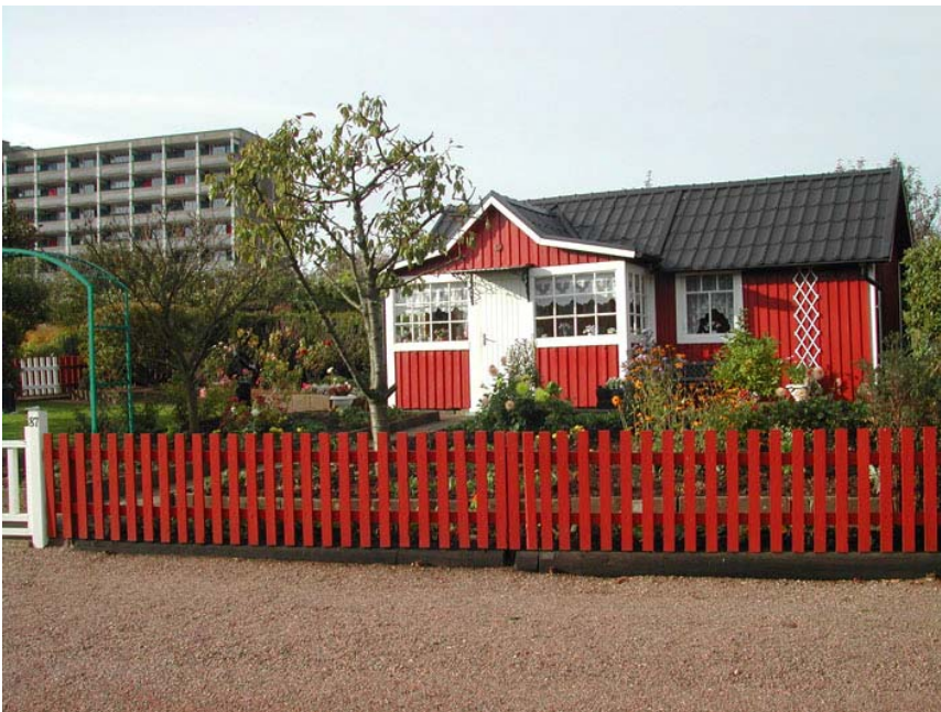
Påbyggd gammal stuga med plåttak i trädgård nummer 85.
