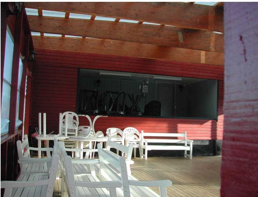
Den enorma dansbanan som medlemmarna har hjälpts åt att bygga.
