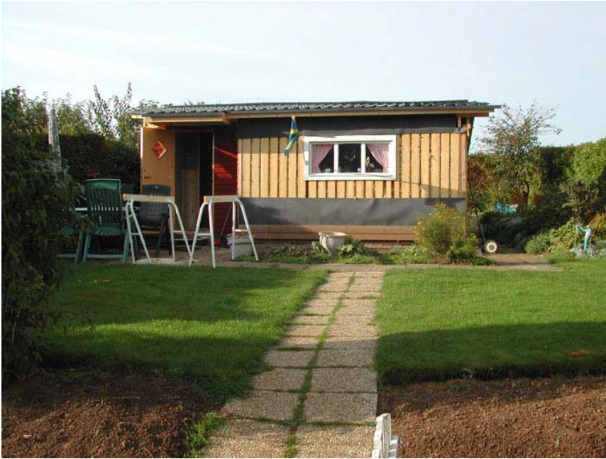
Tilläggsisolering av stuga pågår i koloniträdgård nummer 84.
