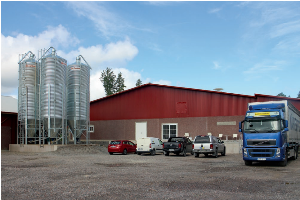
Här syns delar av den nya anläggningen som fått namnet Djursholm.
