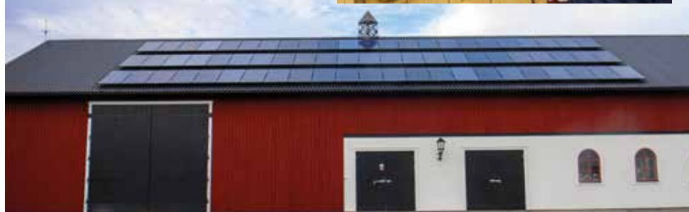
Tomas och Ulla har sina solpaneler på lagårdstaket.
