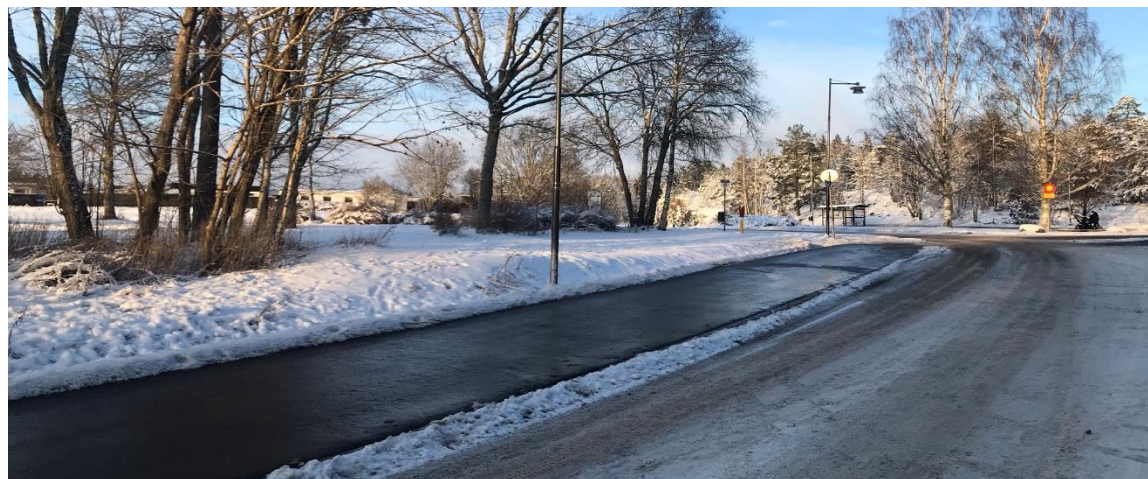
Fotografi på nybyggd gång- och cykelbana utmed Nyforsvägen.
