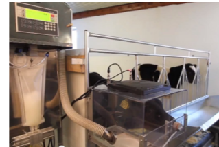
Installation av automatisk kraftfodertilldelning och mjölktilldelning
