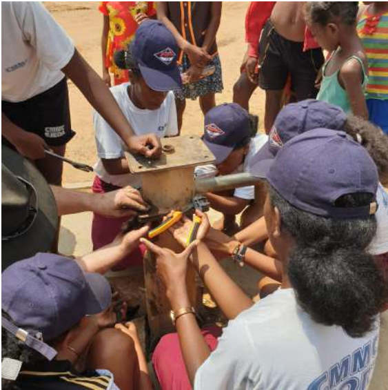
Herstelwerken aan een waterpomp
