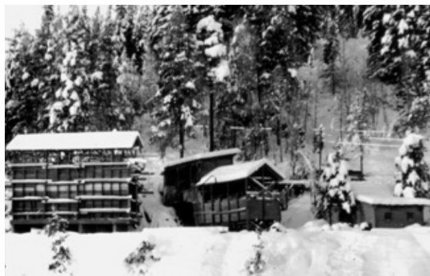
Åmot Pukkverk sitt anlegg på vestsiden av Drammenselva nær Embretsfoss. Bygget til venstre er den nye siloen som ble bygget, mens bygget i midten er den gamle siloen. Siloene sorterte den knuste steinen etter størrelser. Det vesle huset helt til høyre var hoilebrakke, men den rommet også en kraftig kompressor.
