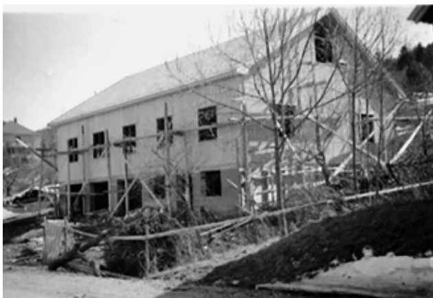
Nytt verkstedbygg under bygging.
