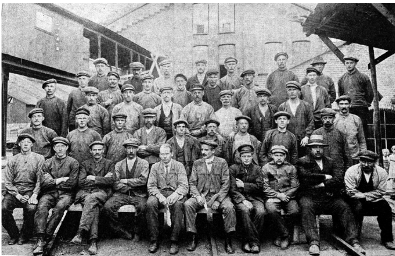
Arbeidere ved Katfos 1908.
