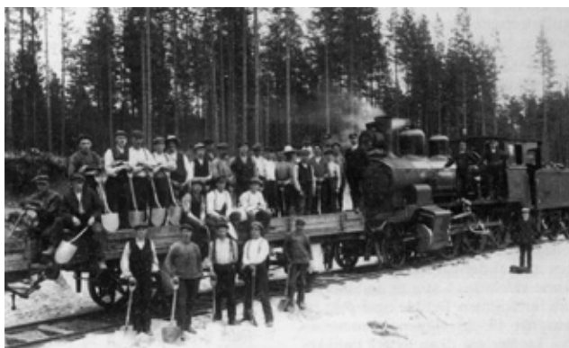
Når grusballasten til det nye jernbanesporret skulle ut, måtte det lastes for hånd på enkle flatvogner.
