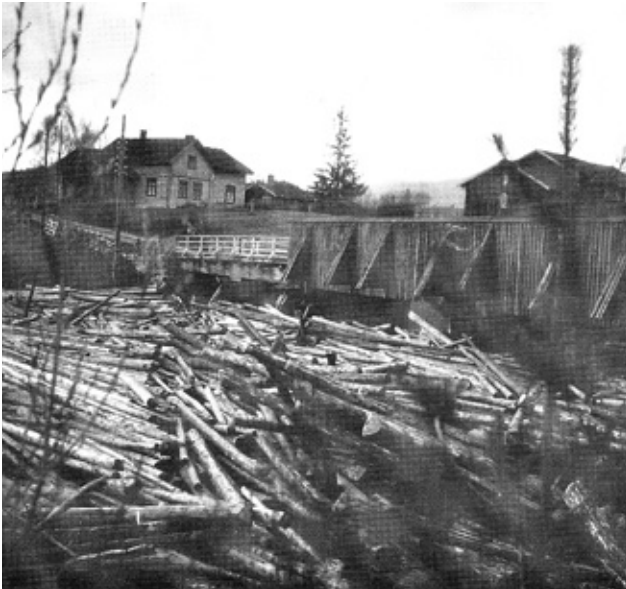
Under storflommen i mai 1916 holdt tømmerstokker fra fløtingen på å få brua til å kollapse. Heldigvis klarte den brasene. Bildet er hentet fra Kai Hunstadbråtens bok om Blaafarvøværket.
