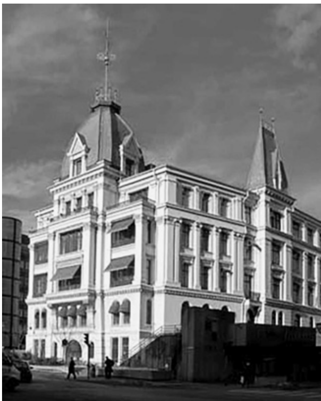
Sydkvartalet av Victoria Terrasse, Vika, Oslo, hvor Riksrevisjonen holdt til. Hovedkvarteret til Gestapo lå i samme bygningskomplekset.
