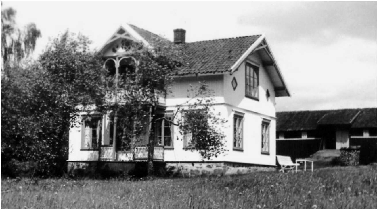
Eiendommen «Kaldaaker» 45/3 i 1937/38. Huset ble antakelig bygd rundt 1900. På grunn av feil i det elektriske anlegget brant huset i 1940. Tyskerne brukte grunnmuren til det nedbrente huset som stilling da de kom til Norge.
