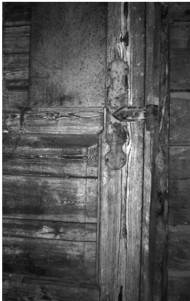
Detalj av det opprinnelige inngangspartiet.
