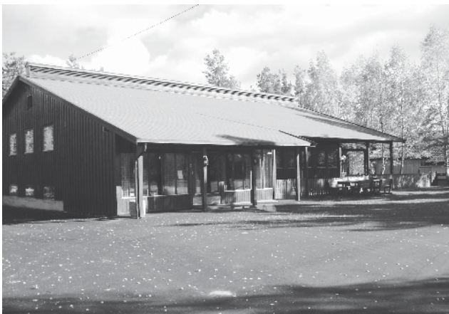
I 1976 sto nye Solhov grendehus ferdig, en storstue for hele Modum. Det eies av bygdas foreninger i et andelslag.
