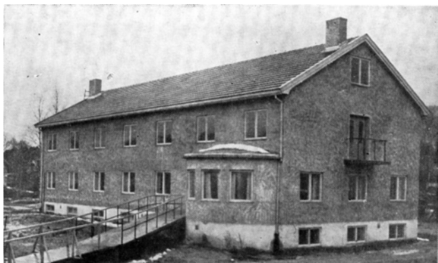
Internatbygningen i Dælveien, Geithus, 1954.
