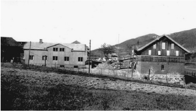
Pleiehjemmet 1950, sett fra sør. Hovedbygningen på gården Sevalds er ombygd til pleiehjem.
