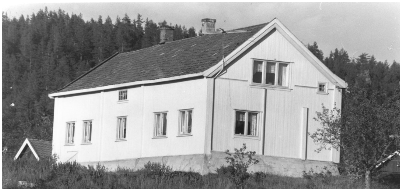
Hovedbygningen på Øvre Gubberud slik vi ser den fra riksveien.
