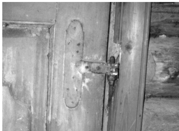
Døra i andre høgda har «himsmidde hengsler». I tverrveggen er det også rundt, utelja tømmer.
