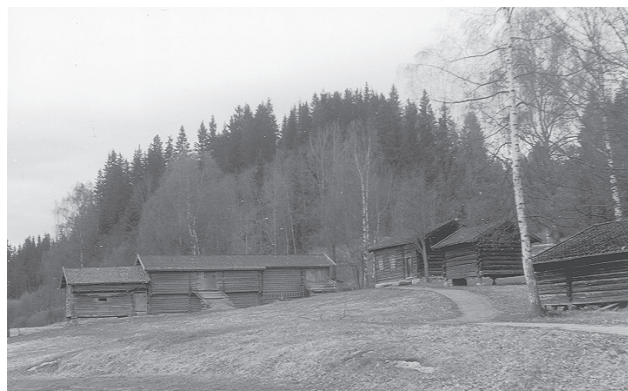
Det påbegynte bygdemuseet slik det ser ut nå (bondegården på Blåafarveværket).
